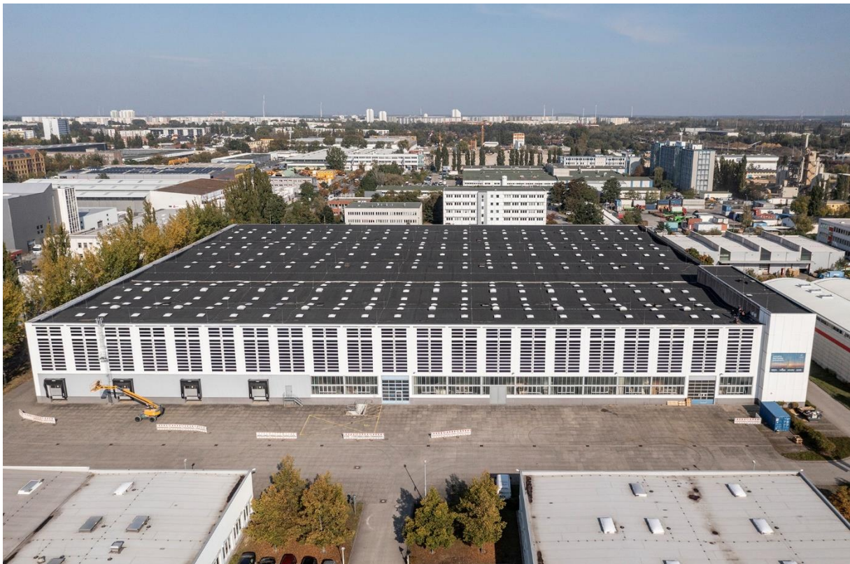
Bild 1: Die Bestandsimmobilie von GARBE in der Marzahner Straße in Berlin mit den integrierten HeliaSol ® Solarfolien.
