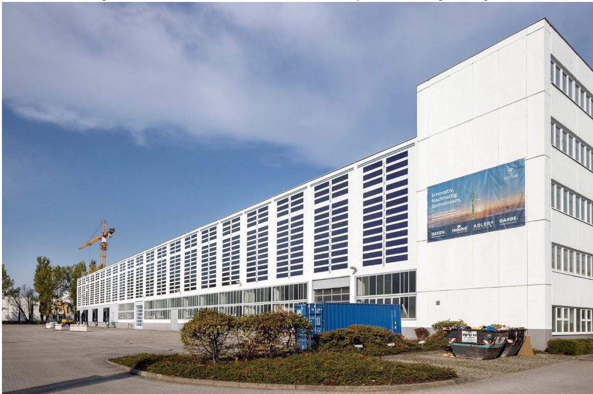
Bild 3: Das Gemeinschaftsprojekt von GREEN, Heliatek und ADLER Smart Solutions wird im Rahmen des „LIFE“-Programmes durch die EU-Kommission gefördert und ist ein Pilotprojekt der GREEN zur Maximierung des CO 2 -Einsparpotentials von Gebäuden.
