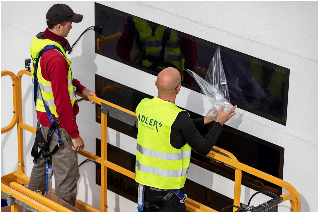
Bild 2: Mithilfe des integrierten Rückseitenklebers können die HeliaSol ® Solarfolien präzise vom Montageteam angebracht werden.
