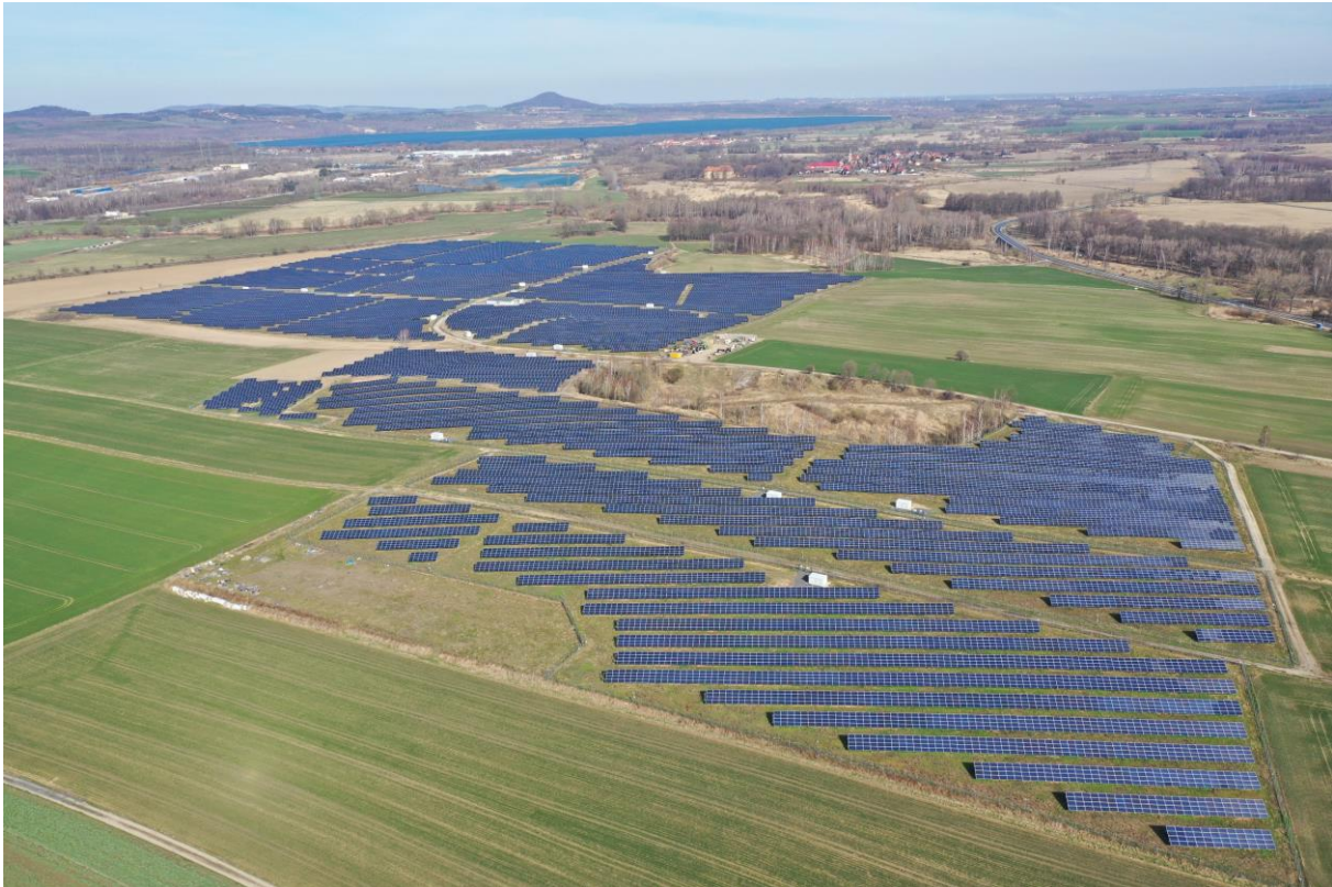
Freiflächenanlage ReneSola Power in Ręczyn, Polen mit 17 MW Bildrechte: ReneSola Power
